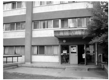
▲鉄筋造りの白金女子寮新館
